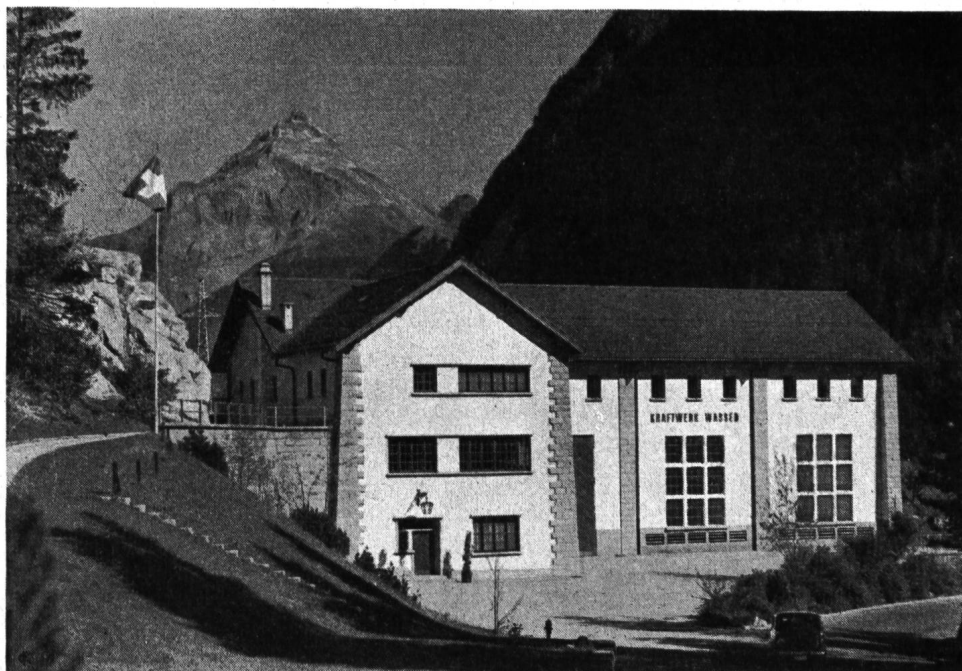
Zentrale des Kraftwerkes Wassen an der Reuß. Blick talauswärts gegen die Kleine Windgälle.
