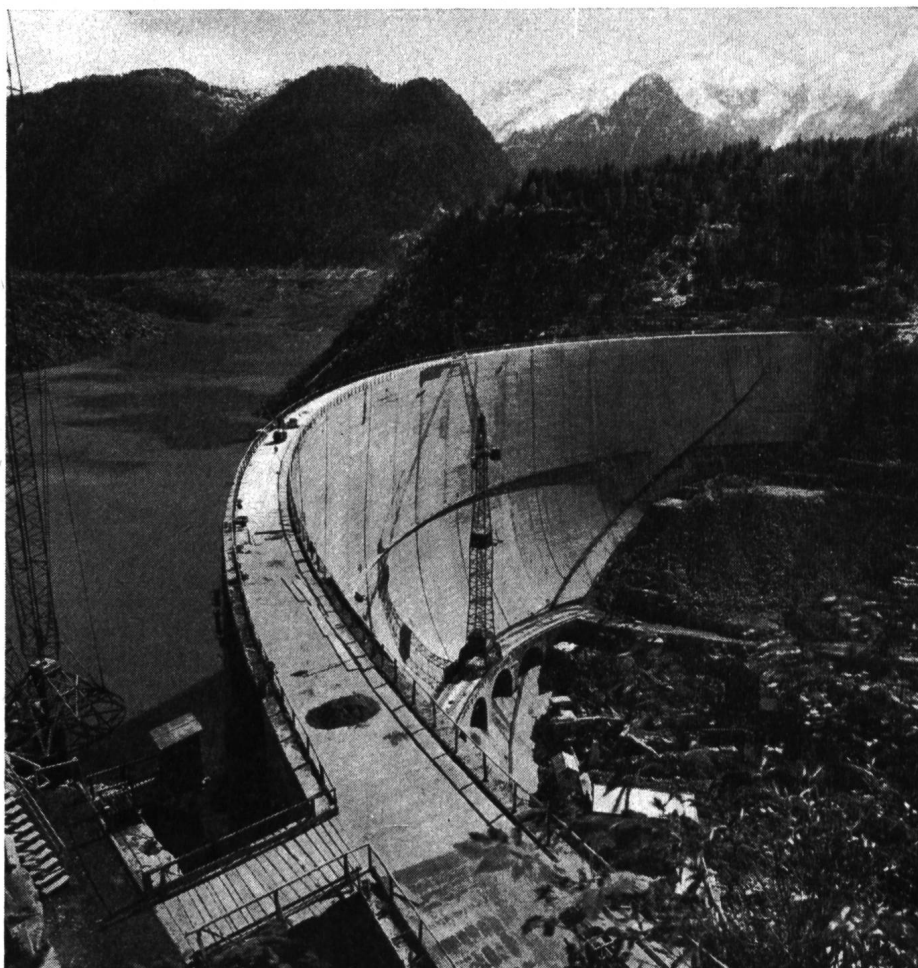
Staumauer Forte Buso der Soc. SMIRREL, Italien. 120 000 m 3 wurden mit einem gewöhnlichen Air-Entrainer betoniert, die restlichen 140 000 m 3 mit FRIOPLAST zur Erlangung einer höheren Betonqualität.
