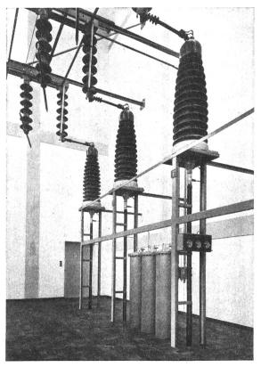
150 kV-Oelkabelendverschlüsse im Unterwerk Schoßhalde des Elektrizitätswerkes Bern
