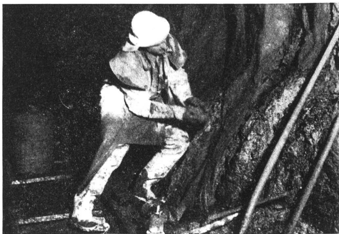
Maggia-Kraftwerke, Galleria Verbano Vordichtung mit BARRA Rapid U
