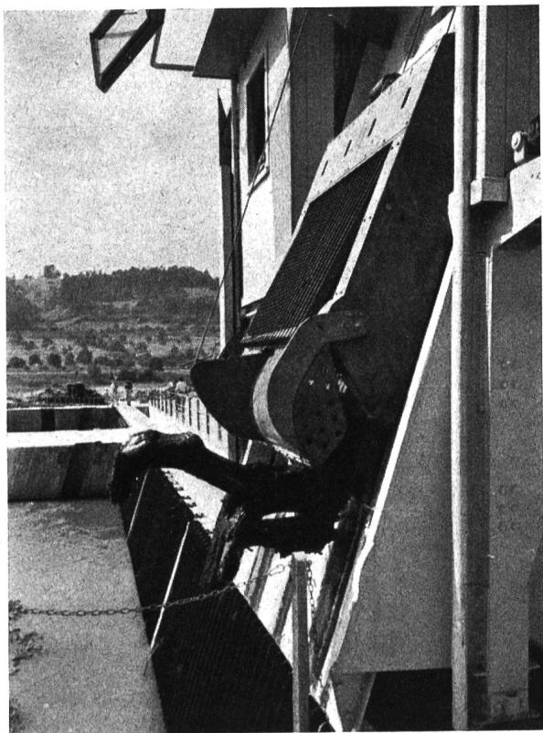
Rechenreinigungsmaschine mit neuer patentierter Greiferharke ausgerüstet
