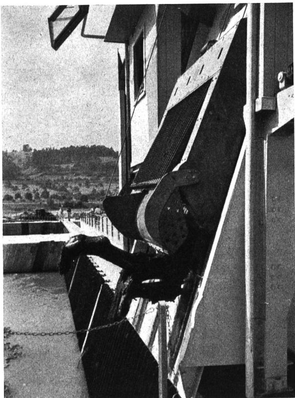
Rechenreinigungsmaschine mit neuer patentierter Greiferharke ausgerüstet
