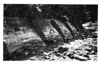
Abb. 8 Nollatobel. Verkleidung der Flügeldämme einer modernen Quersperre mit dachziegelartig übereinanderliegenden Betonplatten, die dem Bergdruck ohne Schaden nachgeben können, von der Bacherosion aber sehr rasch zernagt werden. Zustand am 4. 9. 1951
