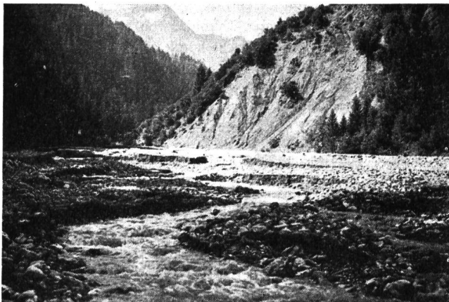
Abb. 5 Nollatobel von E. Links der steile, aber standfeste und gut bewaldete Hang gegen den Piz Beverin, rechts der aufgelockerte Rutschhang des Heinzenberges. Durch Quersperren ist jede Tiefenerosion unterbunden und die Bachsohle stark erhöht und verbreitert worden. Die Seitenerosion verhindert eine geschlossene Bewaldung. Zustand am 4. 9. 1951
