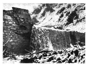
Abb. 7 Nollatobel. Zerdrückte Quersperre infolge des Bergdruckes vom Heinzenberghang her (im Bild von rechts). Zustand am 11. 8. 1952
