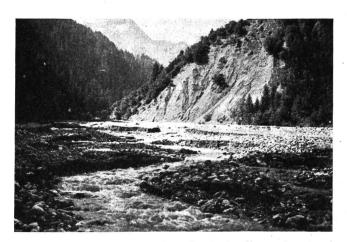
Abb. 5 Nollatobel von E. Links der steile, aber standfeste und gut bewaldete Hang gegen den Piz Beverin, rechts der aufgelockerte Rutschhang des Heinzenberges. Durch Quersperren ist jede Tiefenerosion unterbunden und die Bachsohle stark erhöht und verbreitert worden. Die Seitenerosion verhindert eine geschlossene Bewaldung. Zustand am 4. 9. 1951
