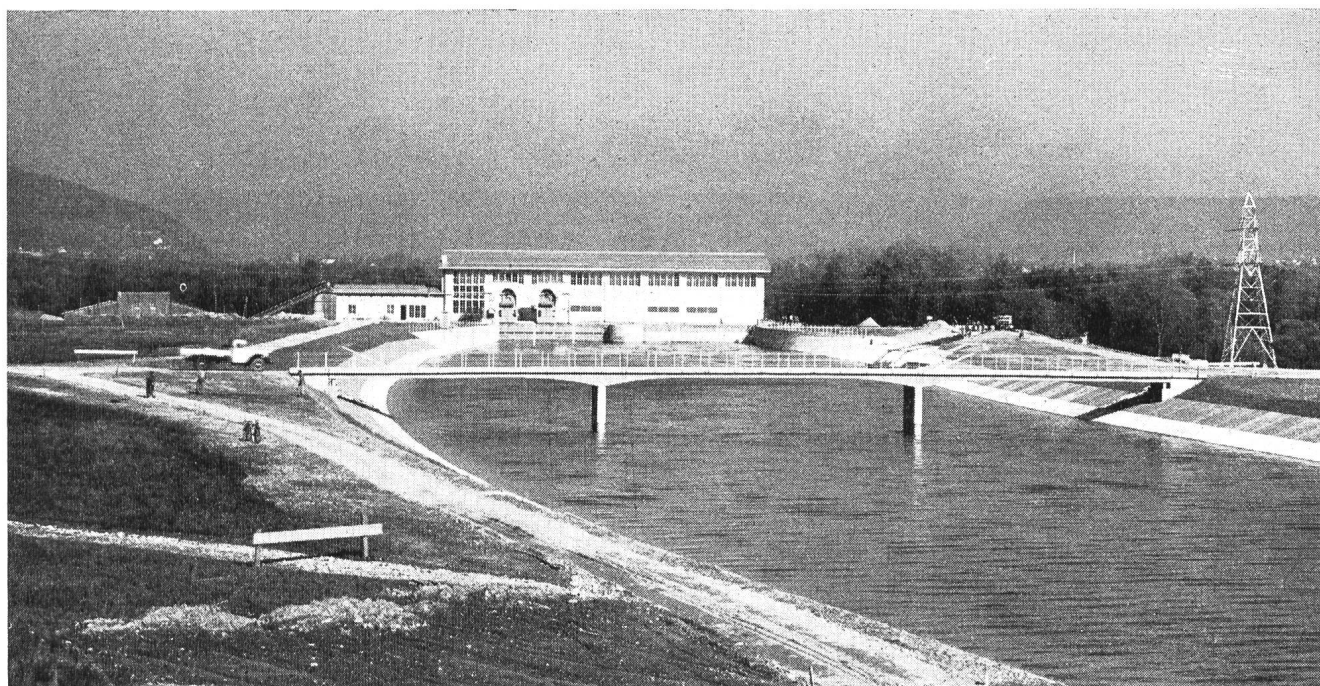
L'usine de Wildegg-Brugg vue du canal d'aménée. L'emplacement de l'écluse est prévu à gauche du petit bâtiment. Photo: H. Wolf-Bender's Erben, Zürich
