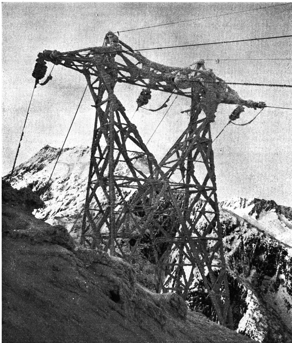
Abb. 15 Abspannmast der Gotthardleitung
