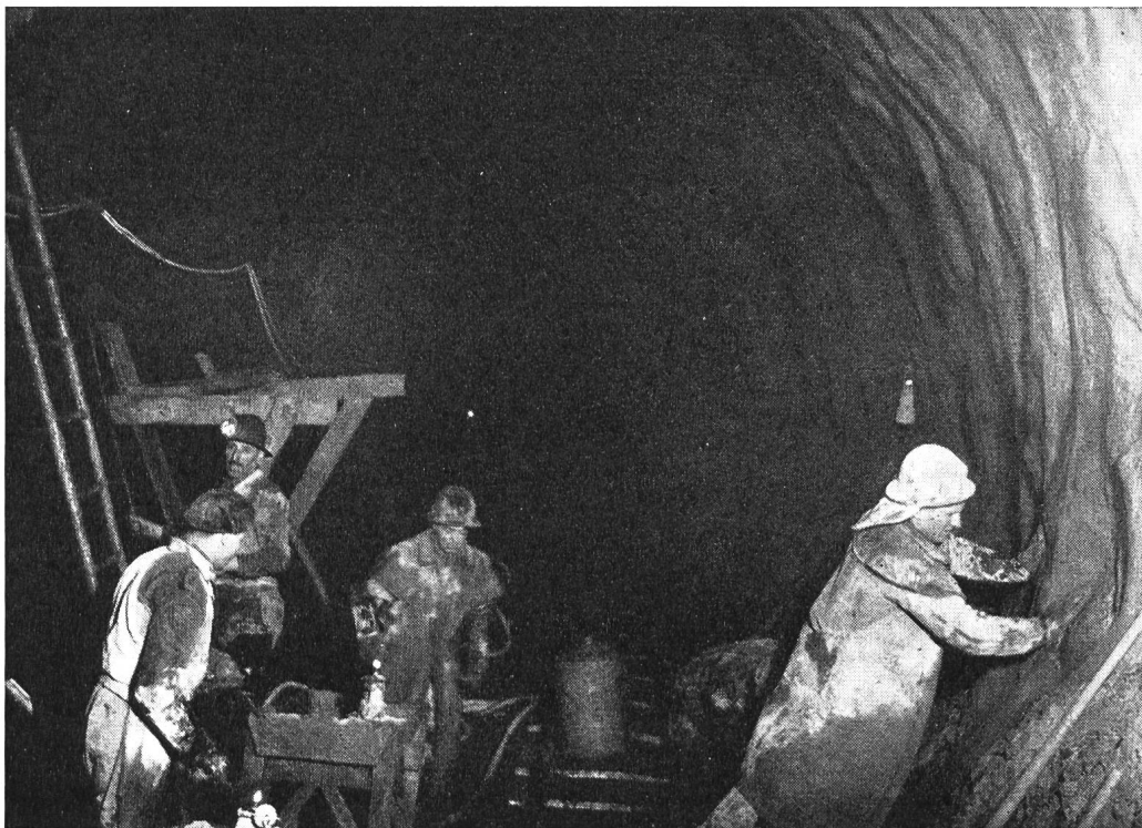
Abdichtungsarbeiten im Druckstollen von Verbano mit Sika 4a durch Arbeiter einer Unternehmung, die durch unsere Sika-Spezialisten angelernt wurden.
