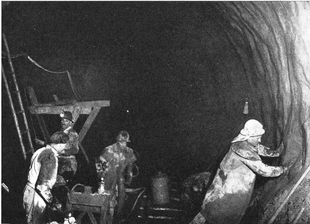
Abdichtungsarbeiten im Druckstollen von Verbano mit Sika 4a durch Arbeiter einer Unternehmung, die durch unsere Sika-Spezialisten angeleitet wurden.
