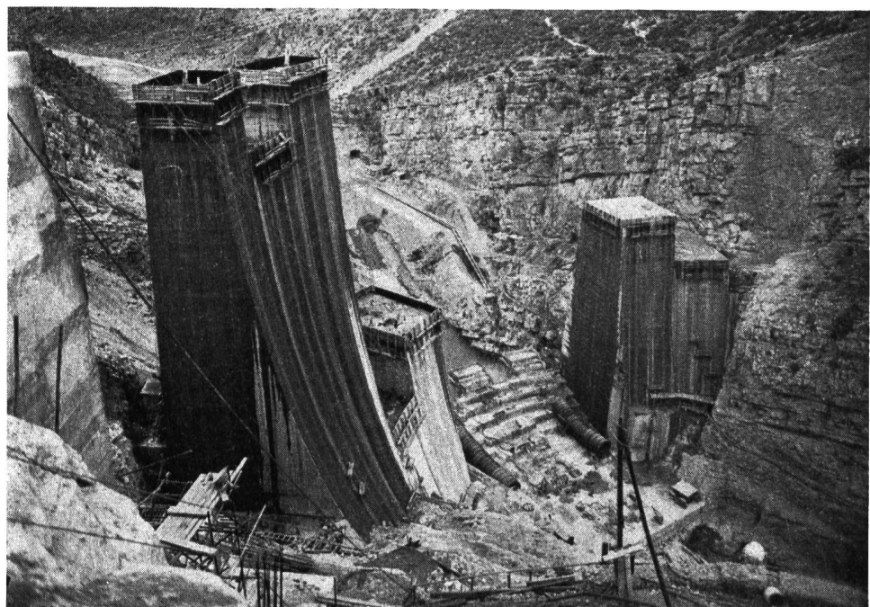
Fig. 7 Barrage de Bin el Ouidane. Vue prise de l'aval le 10 sept. 1951: bloc 13 à la cote 803,00; conduites forcées des blocs 5 et 7 en cours de montage. (Photo Gillot - Casablanca)
