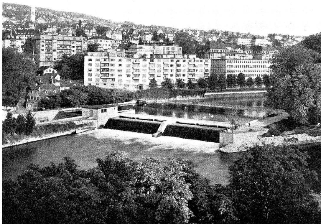
Abb. 14 Hydraulische Dachwehranlage beim Platzspitz
