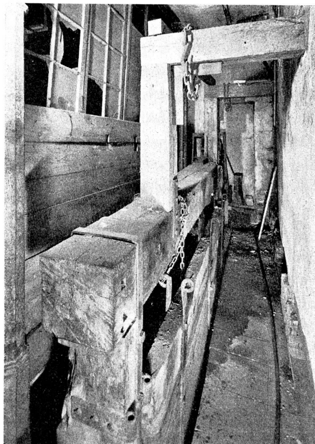
Abb. 4 Freischleuse im Gebäude oberer Mühlestieg No. 10
