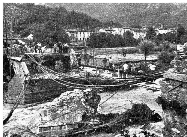
Abb. 7 Die eingestürzte Brücke der Kantonsstraße bei Taverne (Photo Marino, Bellinzona)
