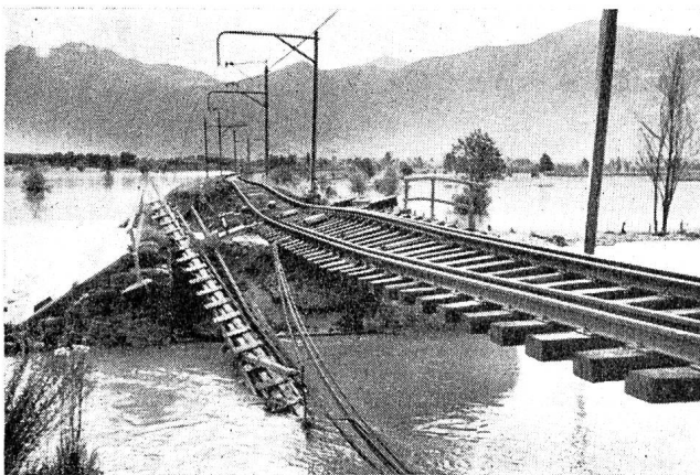
Abb. 4 Bei Riazino wurde durch das Hochwasser der Damm der Eisenbahnlinie Bellinzona—Locarno unterspült (Photo E. Steinemann, Locarno)
