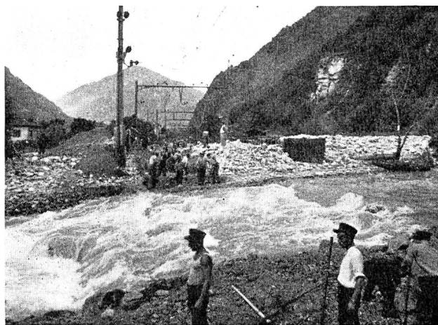
Abb. 5 Der Bach Boggera, der zum reißenden Strom wurde, hat bei der Station Osogna-Cresciano die Gotthardlinie mit großen Mengen Geschiebes überdeckt (Photo Marino, Bellinzona)
