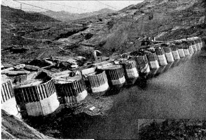
Staumauer Lucendo im Bau
