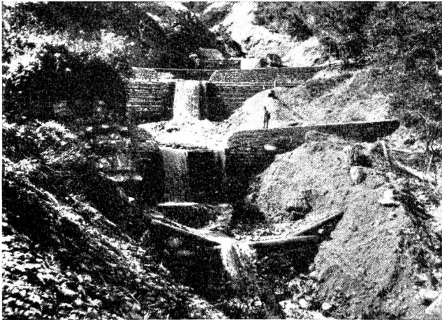
Abb. 4 Kombinierte Sperren Holz-Stein im Casolfbach (Prätigau)
