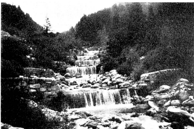
Abb. 6 Verbauung im Urgestein (Orlegna im obren Bergell)
