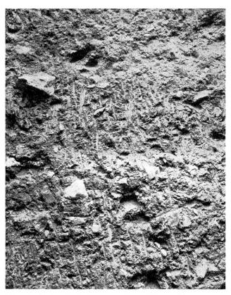
Abb. 27 Struktur des in Lagen von 15 cm Stärke geschütteten und mit Schaffußwalzen verdichteten Kernmaterials. Die Aufnahme zeigt die Wandung eines Kontrollschachtes
