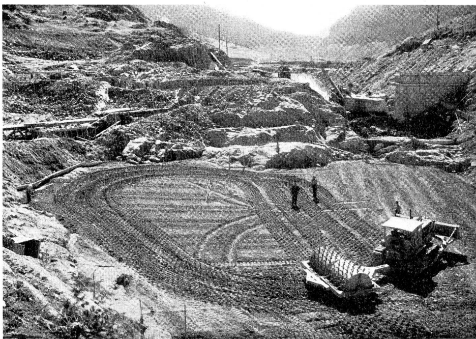
Abb. 21 Verdichten des Kernmaterials mit Schafffußwalzen von 18 t Gewicht und 30—40 kg/cm 2 spezifischer Pressung Photo H. Steiner, St. Moritz
