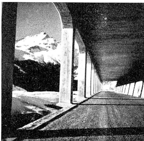
Abb. 4 Steinschlaggalerie an der neuen Julierstraße, Blick gegen Norden auf Piz d'Arblatsch
