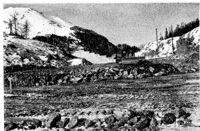
Abb. 26 Ausbreiten von Material (3) in Schichtstärke von 1 m mit schwerem Bulldozer
