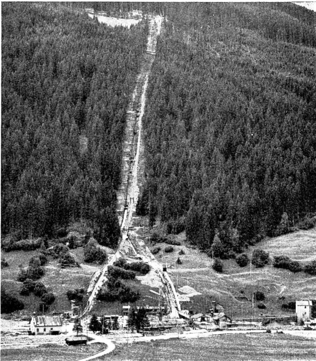
Abb. 17 Druckleitung, im Vordergrund Baustelle der Zentrale
