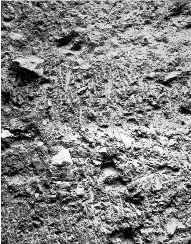
Abb. 27 Struktur des in Lagen von 15 cm Stärke geschütteten und mit Schafffußwalzen verdichteten Kernmaterials. Die Aufnahme zeigt die Wandung eines Kontrollschachtes
