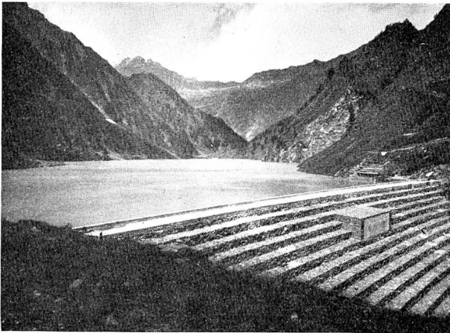
Abb. 21 Steinsatzdamm des Stausees Alpe Cavalli in der oberen Valle d'Antrona, Blick gegen den Grenzkamm Italien—Schweiz (Photo Soc. Edison, Milano)
