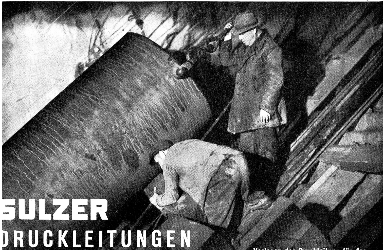
Verlegen der Druckleitung für das Speicherkraftwerk Salanfe. Betriebs-
