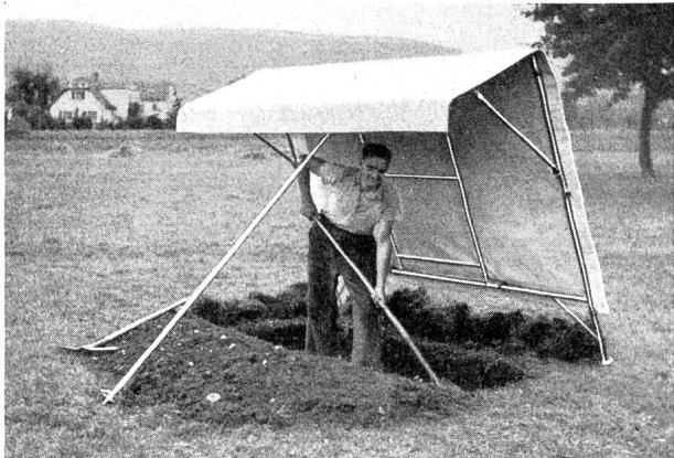
Jede Arbeit wird schneller und zuverlässiger fertig, wenn die Launen des Wetters ihre Schrecken verlieren. Das BACHER-Zelt ist nicht nur ein zuverlässiger Schutz sondern dadurch auch rasch amortisiert. Aus verzinktem Stahlrohr konstruiert, ist das BACHER-Schutzzelt leicht und handlich. Es kann zusammengeklappt werden und ist in der Ausladung verstellbar. Die verzinkte Ausführung und die mit soliden Lederriemen aufgeschnallte Blache aus bester Hanfsegelqualität bilden für größte Lebensdauer.
