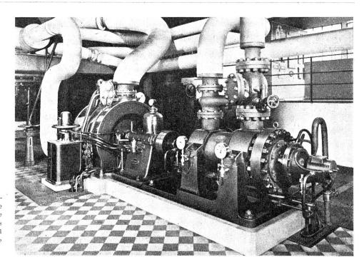
Durch eine Sulzer-Dampfturbine angetriebene siebenstufige Hochdruck-Kessel-Speisepumpe im Dampfkraftwerk Comines der Energie Electrique du Nord de la France; Fördermenge 38.8 l/s, Förderhöhe 657 m.
