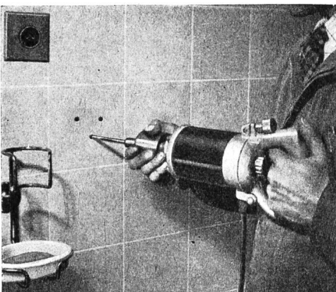
Abb. 12 «Dübeln» in Steingut mit dem Elektrohammer. Man beachte die maßhaltigen Löcher. (Perles.)
