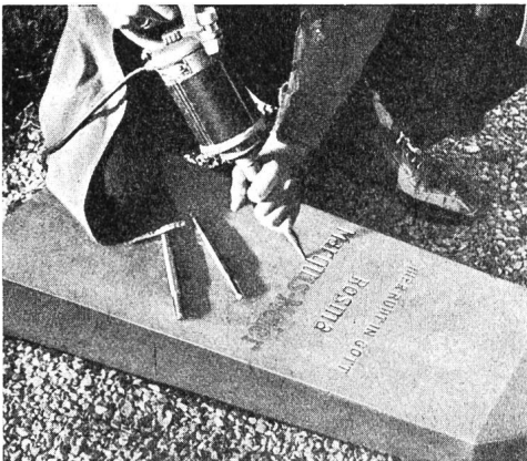
Abb. 11 Eingravieren von Inschriften mit dem Elektrohammer. (Perles.)
