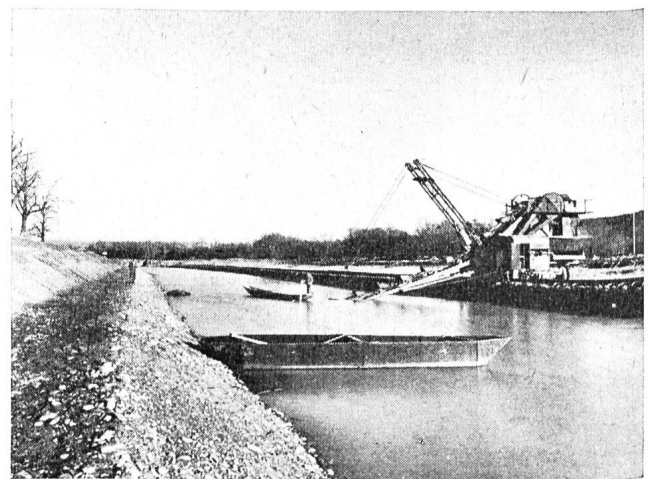
Abb. 13 Unterwasserkanal Wildeggen-Brugg, Aushub unter Grundwasser
