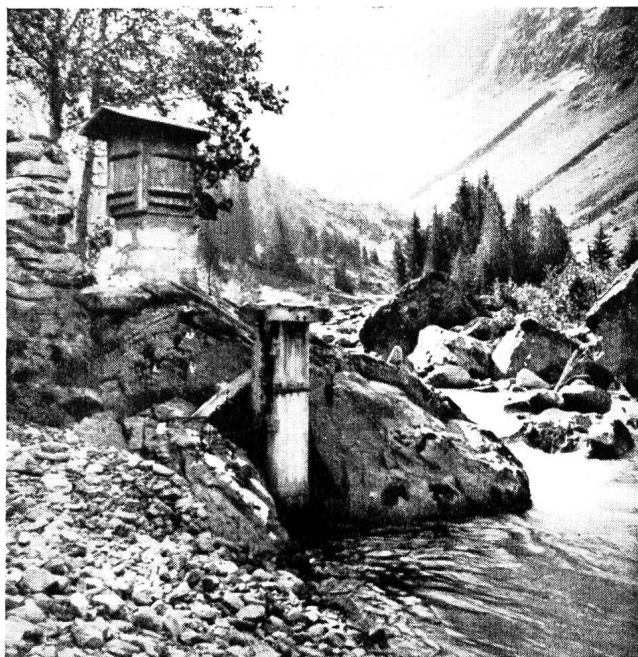
Abb. 2 Wassermessstation Alp Sutgatschär (Somvixer Rhein)
