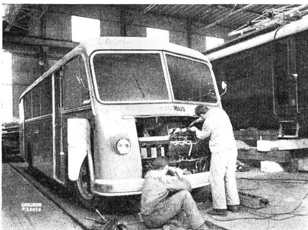
motor ausgebildeten Fahrmotor. Die Wiederaufladung des Schwungrades geschieht bei mäßiger Energieaufnahme in kurzer Zeit, so daß dazu die normalen Haltezeiten des Fahrzeugs genügen. Zum Betrieb des Gyrobus dient Drehstrom.
