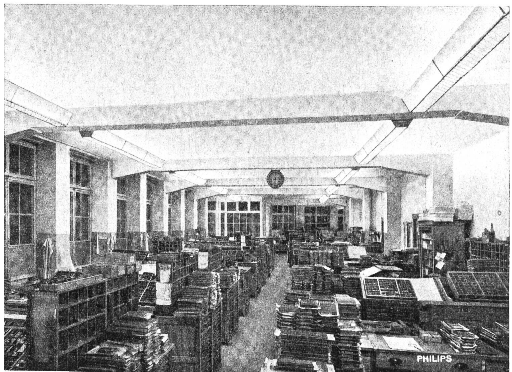
Abb. 9. Beleuchtung einer Setzerei. Mittlere Beleuchtungsstärke 350 Lux. Beidseitig dreiflämmige Leuchtenreihen.
