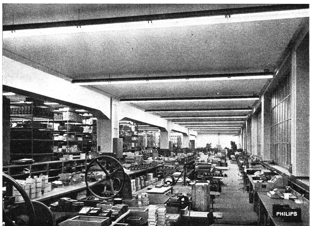
Abb. 7. Apparate mit einfachen Reflektoren für 1 Fluoreszenzlampe 40 Watt, in Reihenanordnung. Mittlere Beleuchtungsstärke 200 Lux.
