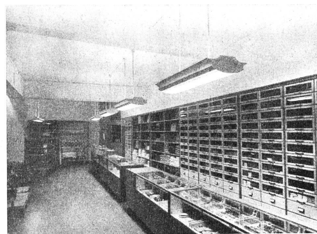
Abb. 11. Ladenbeleuchtung mit Armaturen 1505, bestückt mit 2 TL 40-W-Tageslicht und 2 TL 40 W weiß. Mittlere Beleuchtungsstärke etwa 350 Lux.
