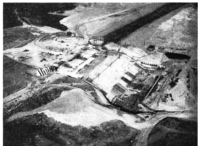
Abb. 11. Enders Dam, Betonieren des 120 m breiten Überlaufbauwerkes. Im Hintergrund (dunkel) dichte Zentralzone.
