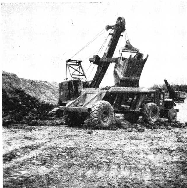
Abb. 15. Neversink Dam, N. Y., Gewinnung des Damm-Materials mit 2,6-m 3 -Löffelbagger und Verladen auf 11-m 3 -Sattelschlepper.
