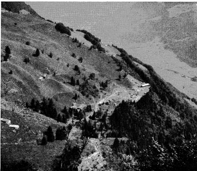
Abb. 11 Kraftwerk Luchsingen II. Baustelle Brunnenberg. Hangzuleitung, Ausgleichbecken, Seilbahnstation.
