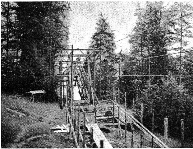
Abb. 10 Kraftwerk Luchsingen II. Durchdringung von provisorischer Luftseilbahn auf Holzböcken und definitiver Luftseilbahn in Eisenkonstruktion.
