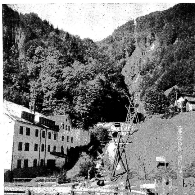
Abb. 9 Kraftwerk Luchsingen II. Provisorische Luftseilbahn und Hilfsseilbahn. Blick längs Schneise, schieß gekreuzt durch Schneise der Druckleitung.
