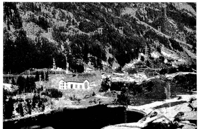
Abb. 16 Zentrale Wassen, Gesamtübersicht. Im Vordergrund Ausgleichsweiher Pfaffensprung des SBB-Werkes Amsteg.
