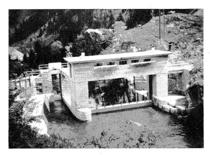
Abb. 1 Stauwehr und Fassung Gotthardreuss, Ansicht vom Oberwasser aus.
