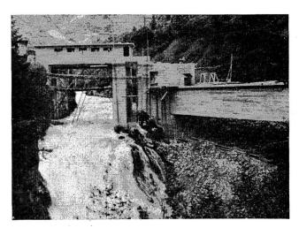
Abb. 9 Stauwehr Gotthardreuss mit Aquädukt.
