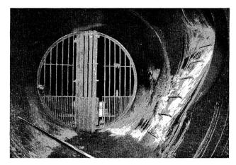
Abb. 14 Druckstollen: Rechen und Wasserschlosseinmündung.
