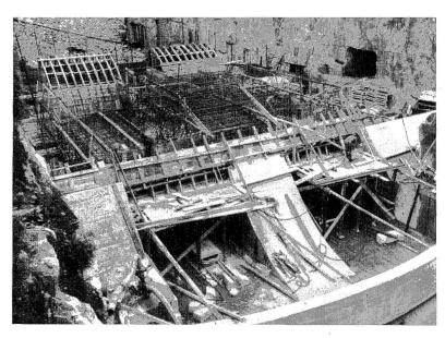
Abb. 7 Staumauer Göschenen: Betonierung der Grundablässe.
