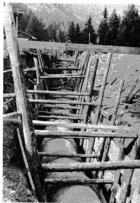
Abb. 11 Saminawerk. Hangleitung, Superbeton-Schleuderröhren \varnothing 100 cm auf der linken Talseite, kurz vor dem östlichen Portal des Druckstollens. (Photo P. Ospelt, Schaan)
