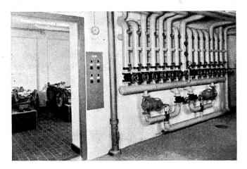
Fig. 32 Heizungsverteilanlage und links Blick in den Wärmepumpenraum.
