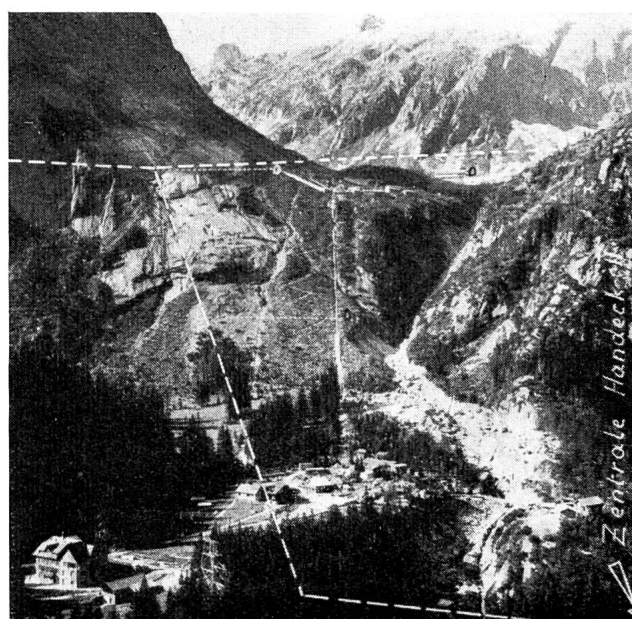
Abb. 9 Der Druckschacht mit den Zuleitungsstollen von Rätherichsboden (links) und vom Gauligebiet (rechts) her. In den Kreisen die Baufenster Aerlen (rechts oben), Handeckfluh (Mitte oben) und Druckschacht (Mitte unten).
