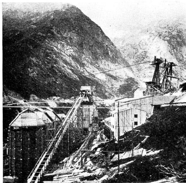
Abb. 8 Installationen für den Bau der Staumauer Rätherichsboden. Links Materialsilos, rechts Kabelkranstützen.
