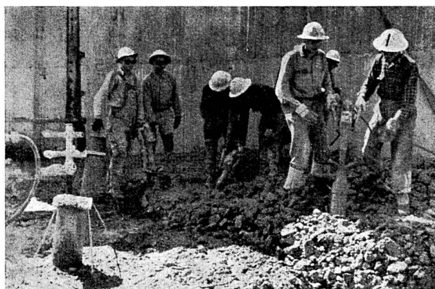
Abb. 5 Wolf Creek Dam. Vibrieren des Betons mit 150\text{ mm} Maximal Korn.
