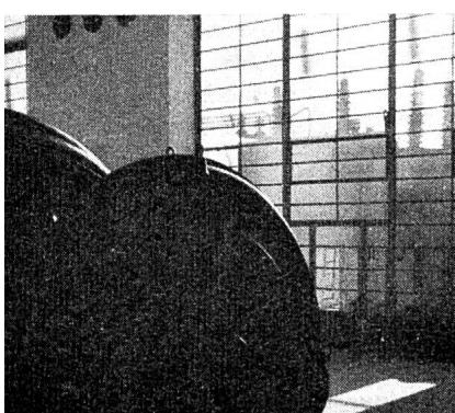
Der im Generator erzeugte elektrische Strom wird für die Übertragung auf grosse Entfernung im Transformator auf hohe Spannung gebracht. Lautlos und mit Lichtgeschwindigkeit wird dann die Kraft des Wassers zu den Verbrauchsorten geleitet.
