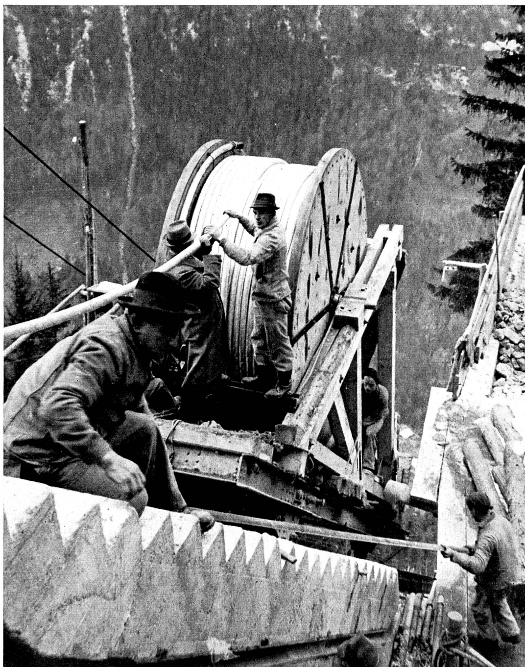
GRIMSEL Verlegung des Dreibleimantelkabels Urweid-Wasserschloss 3 x 1 x 16 mm 2 , 16 kV. Länge 1065 m. Höhenunterschied 630 m
