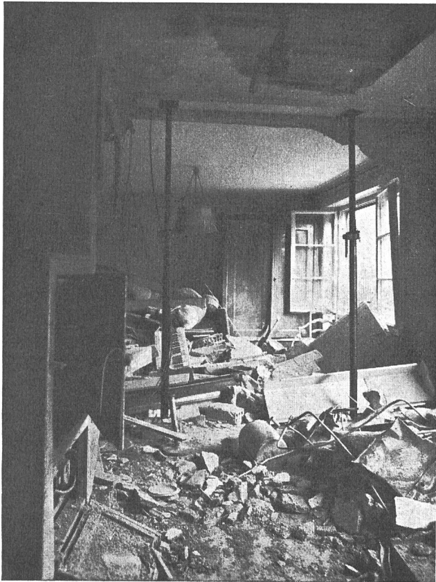
Fig. 20 Die Mauer, an der der Herd stand, wurde mit Wucht in das dahinterliegende Zimmer geworfen. Das zerstörte Klavier zeigt die Wucht der Explosion.
