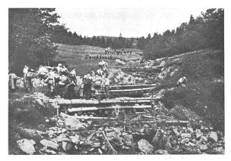
Abb. 12 Provisorische Verbauung des Wissibaches. Photo Ing. Rieser.
