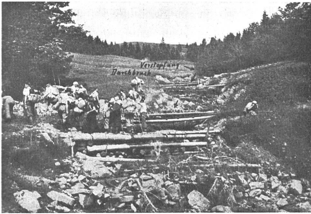
Abb. 12 Provisorische Verbauung des Wissibaches. Photo Ing. Rieser.
