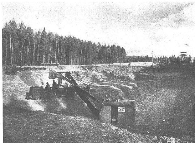
Abb. 9 Aushub der Maschinenhausbaugrube. Bauzustand vom 27. November 1946.
