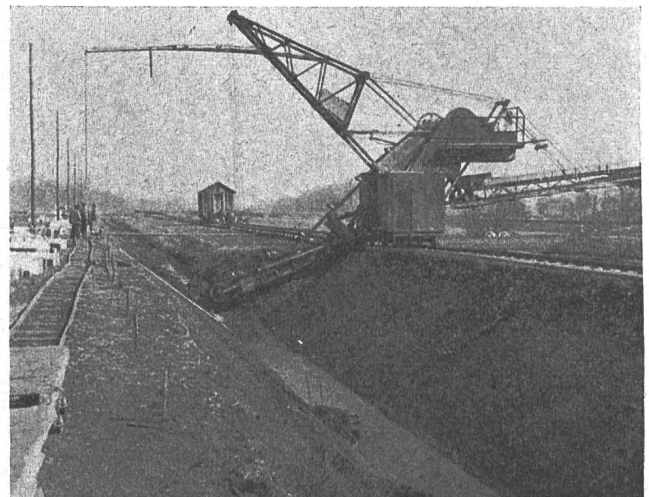
Abb. 15 Eimerkettenbagger auf Geleise mit Transportband.
