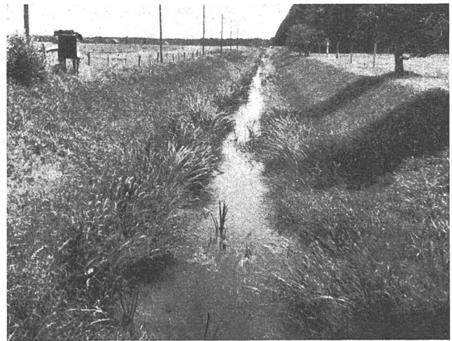
Abb. 10 Hauptkanal mit seitlicher Verkrautung.
