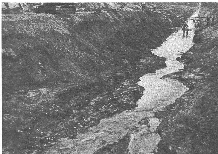
Abb. 17 Einbau der Sohlensicherung im Hauptkanal bei Müntschemier.
