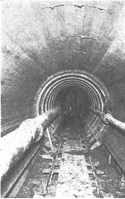
Abb. 19 Ausbetonierter Stollen mit eiserner Schalung.
