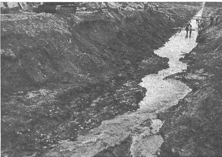
Abb. 17 Einbau der Sohlensicherung im Hauptkanal bei Müntschemier.
