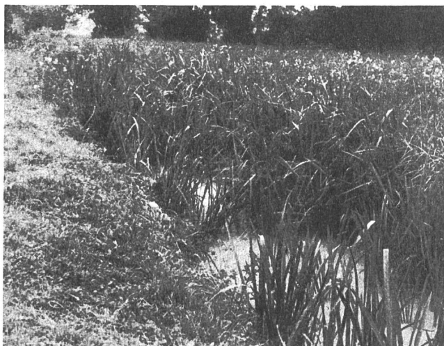
Abb. 6 Verkräutung im Graben ohne Sohlensicherung.
