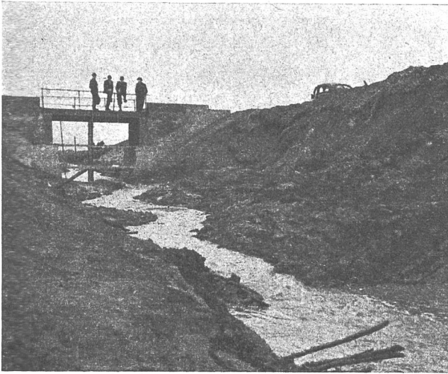
Abb. 16 Hauptkanal bei Müntschemier vor dem Einbau der Sohle.
