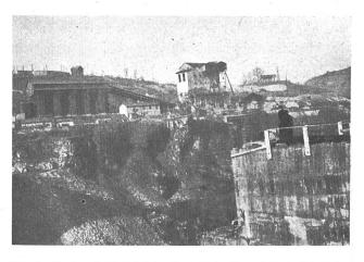
Abb. 4 Kraftwerk Génissiat im Bau. Links Zementsilo, rechts Beton-aufbereitung. (15.1.47).
