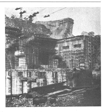
Abb. 3 Kraftwerk Génissiat im Bau. Noch offene Halle des Maschinenhauses mit Kran; Staumauer (15.1.47).
