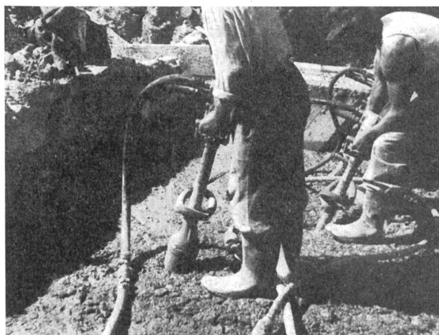
Abb. 16 Staumauer, Betonrüttler.
