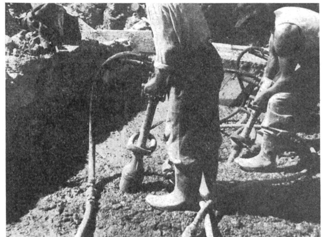
Abb. 16 Staumauer, Betonrüttler.
