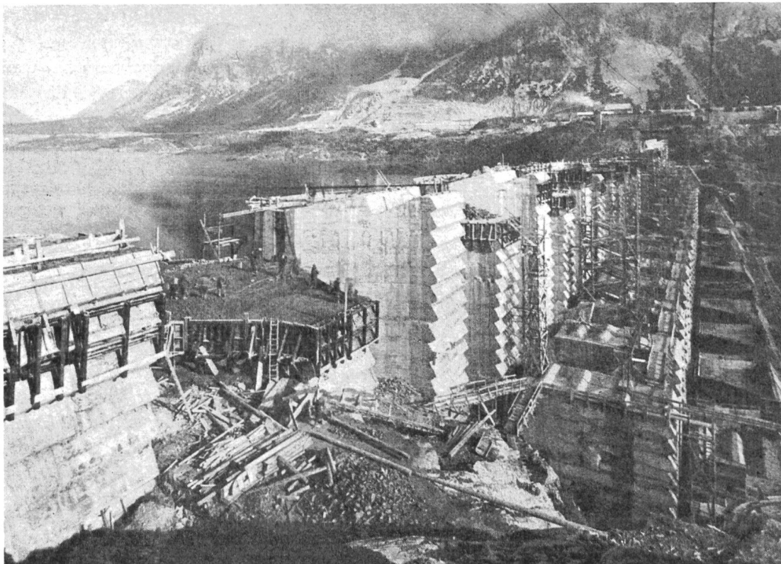
Abb. 9 Staumauer S. Giacomo di Fraele, Stand der Arbeiten am 13. Oktober 1943.
