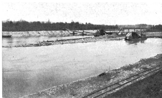
Abb. 16 Aarevertiefung mit schwimmenden Eimerkettenbaggern.
