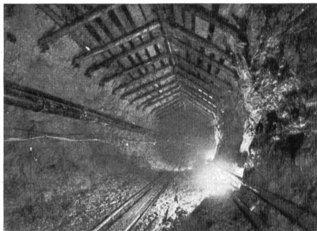
Abb. 8 Aushub des Druckstollens und Stirnschutz gegen das Fallen von Felsblöcken im Los III.
