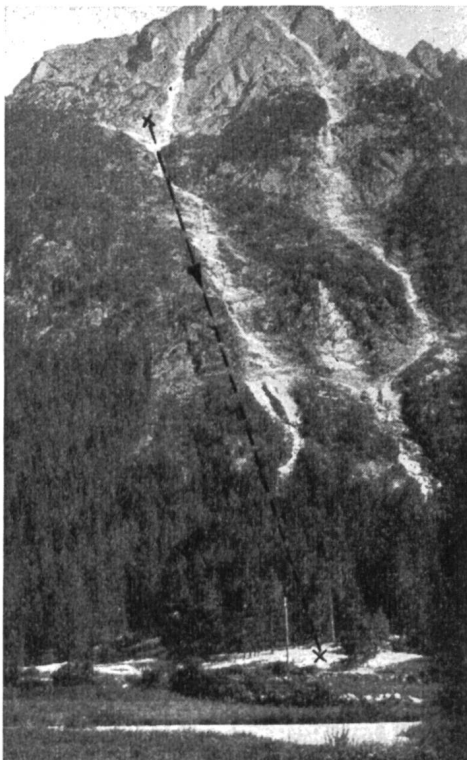
Abb. 11 Kraftwerk Albigna, Druckleitungstrasse (Konzessionsprojekt).
