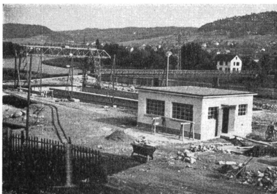
Abb. 2 Abwasserpumpwerk mit den beiden Klärbecken und dem Portalkran.
