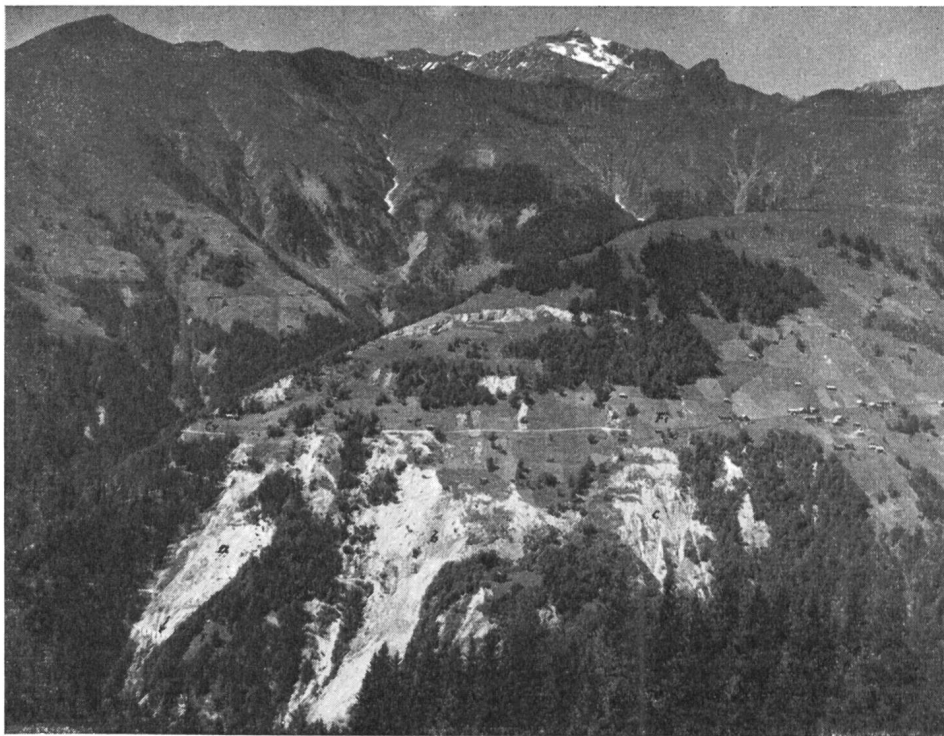
Abb. 21 Ansicht der Schuderser Rutschungen von Oberstels aus.
