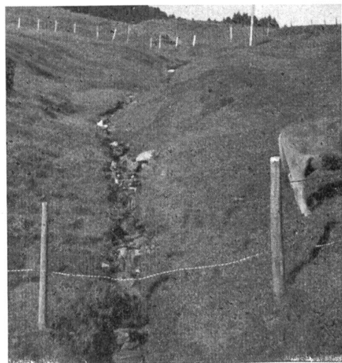
Abb. 15 Solche Steinbettrinnen mit weitem, schalenartigem Profil funktionieren seit Jahrzehnten, sogar Jahrhunderten, trotz starkem Weidgang, Hochwasser usw. Wo solche Gerinne mit selber ausgespültem, schützendem Natursteinbelag fehlen, müssen sie künstlich angelegt werden. (Voralpenweide in Graubünden.)
