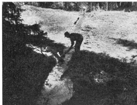
Abb. 4 Wasserführungsarbeiten beim Rufenwald unter der Saaser Alp. Der gefährliche Bach floss vorher über den Hang (im Vordergrund nach rechts, Doppelpfeil) und versickerte bis auf zirka 80 m Länge am unteren Steilhange. Er wurde 1945 in neuer Bachrinne ins nächste Tobel geleitet (Pfeilrichtung).
