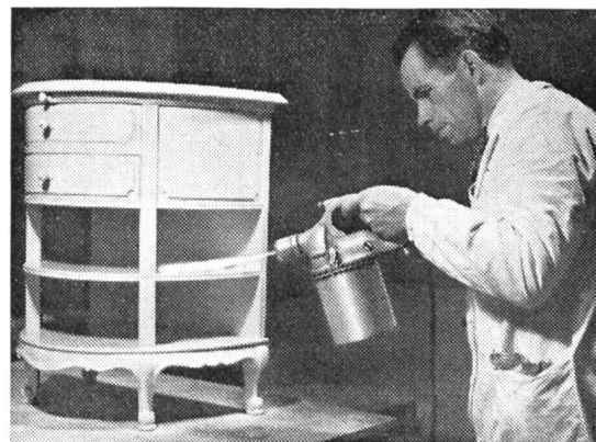
Fig. 8 Die Elektrospritzpistole im Gebrauch.
