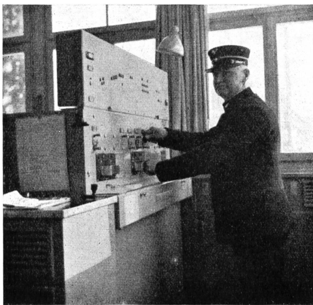
Fig. 1 Das neue, vollelektrifizierte Stellwerk im Bureau
