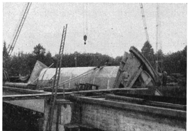
Abb. 6 Obere Schütze. Ueberfallblech und Blechschilde zur seitlichen Führung des Ueberfallstrahles (in Montage).
