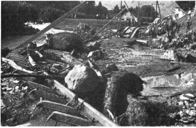
Abb. 4 Unterbrochene Bahnlinie gegenüber der Einmündung des Durnagelbaches (Aufnahme vom 25. August 1944).
