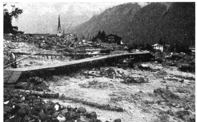
Abb. 8 Die durch Militär erstellte erste Fussgängerverbindung über den ca. 170 m breiten Schuttkegel und reissenden Wildbach.
