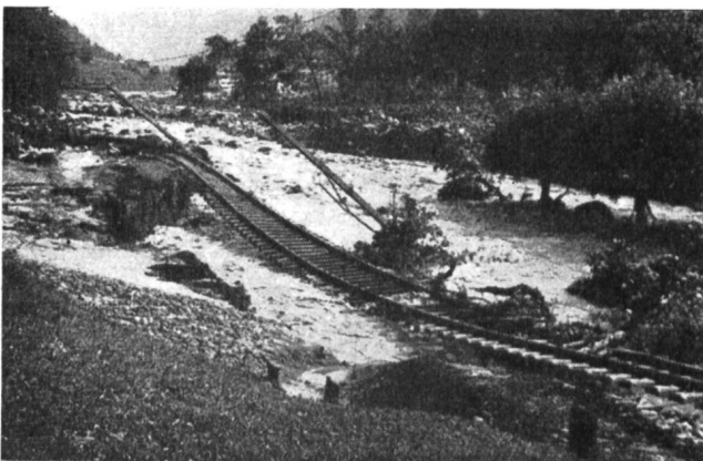
Abb. 5 Unterspültes Bahntracé gegenüber der Einmündung des Durnagelbaches (Aufnahme vom 25. August 1944).
